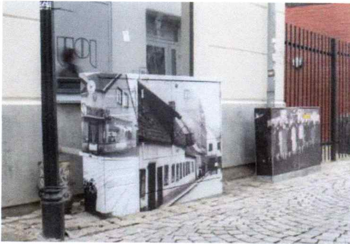
Exempel på klädda elskåp från Norra Strandgatan i Helsingborg
